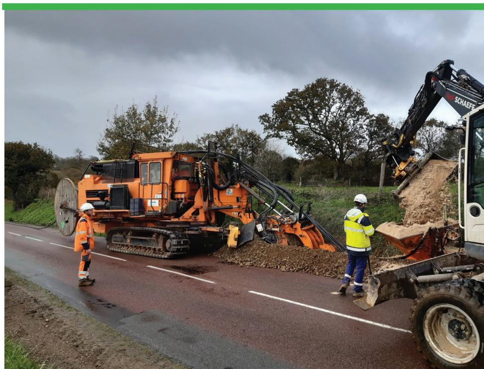
La trancheuse en action sur la RD 68 le 16 novembre 2020. A l'avant, on distingue le touret qui permet de dérouler le câble électrique. A l'arrière, la roue qui réalise la tranchée dans la chaussée
