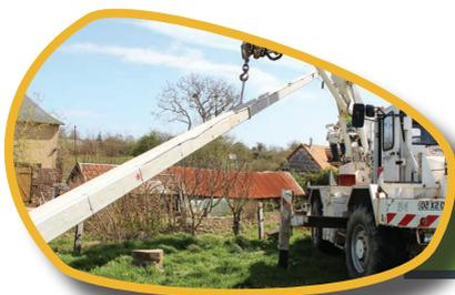
Les travaux de sécurisation réalisés par le Sdem50 consistent à remplacer les réseaux basse tension en fils nus par des réseaux aériens en câble torsadé ou en souterrain.
